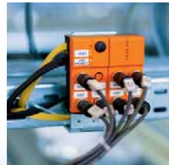
Module ClassicLine : technologie de montage rapide.
