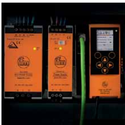
Armoire électrique bien rangée : Les composants en tête du réseau AS-i montés en coffret.
