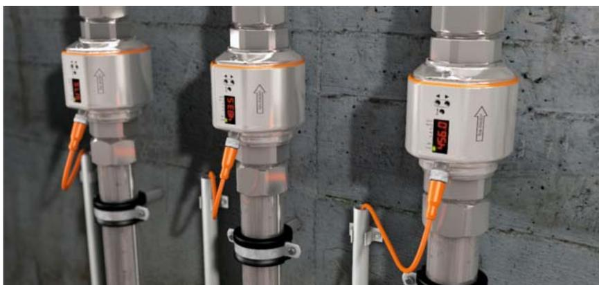
Les capteurs de débit magnéto-inductifs de type SM mesurent le débit de façon précise dans un circuit de refroidissement. Si un défaut se produit, les données de diagnostic sont transmises par le maître au système de commande. Une identification unique du capteur défectueux est assurée.
