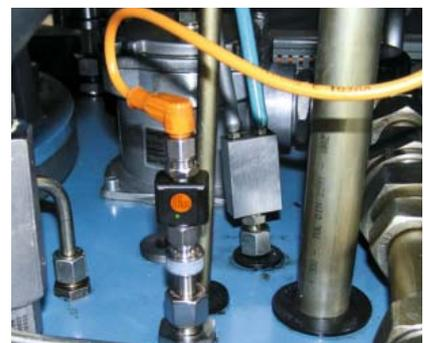
Utilisation d'un transmetteur modulaire TP au lieu d'un transmetteur en tête de sonde ou rail.
